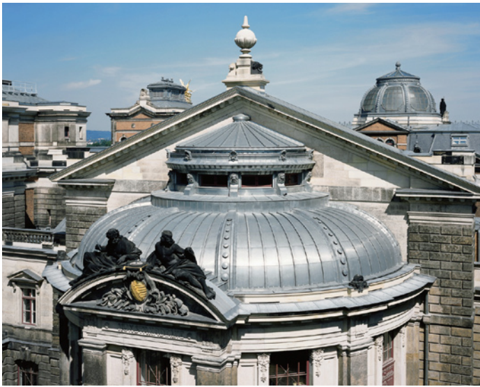
Bild 12.: Hochschule für bildende Künste in Dresden: Zinkdächer sind auch mit anspruchsvollen Geometrien bei Baudenkmalern eine gute Lösung. Ausführung der Klempnerarbeiten: Böhme Haustechnik GmbH, Dresden. (Foto: Rheinzink, Datteln).
